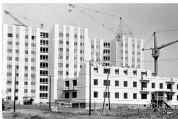
Строительство жилого дома для преподавателей и сотрудников
