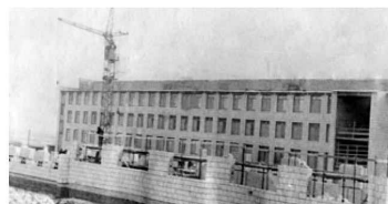
Строительство лабораторного корпуса
