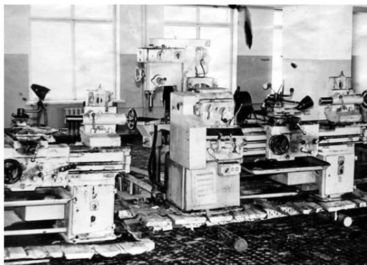
Монтаж станков в механической мастерской
