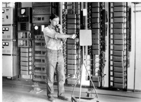
Автоматическая телефонная станция
