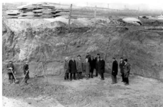
Торжественное открытие строительства главного учебного корпуса техникума
