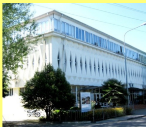
Корпус 3, г. Сочи, ул. Ландышева, д. 12, корп.4. тел: 8 (862) 250-22-62 (Мамайка)
